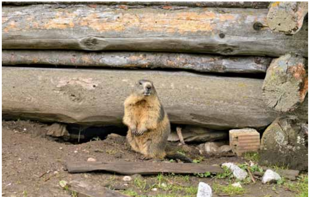
Es gibt auch schon Klagen über Schäden an Almhütten und anderen Infrastrukturen.
